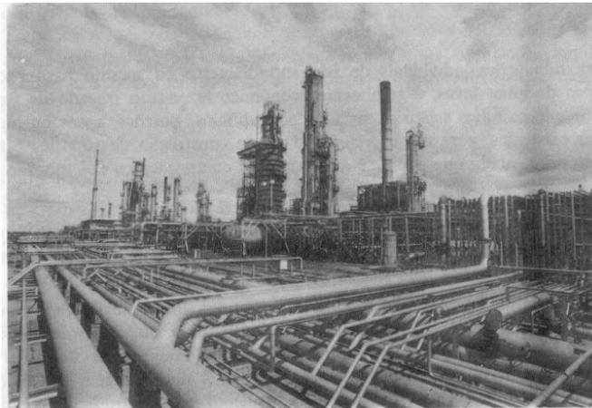
QUANDO AS TUBULAÇÕES DE INTERLIGAÇÃO FOREM DE PEQUENO DIÂMETRO E/OU EM PEQUENA QUANTIDADE, PODE-SE UTILIZAR SUPORTES ELEVADOS COM TRELIÇAS METÁLICAS OU EM ESTRUTURAS DE CONCRETO
